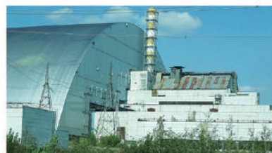
爆発したチェルノブイリ原発4号機を覆う第二石棺 右は3号機(4号機と同形) 2017年 撮影:小寺隆幸
